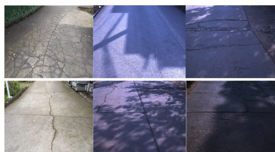
图9 自制路面裂缝数据集样本展示
